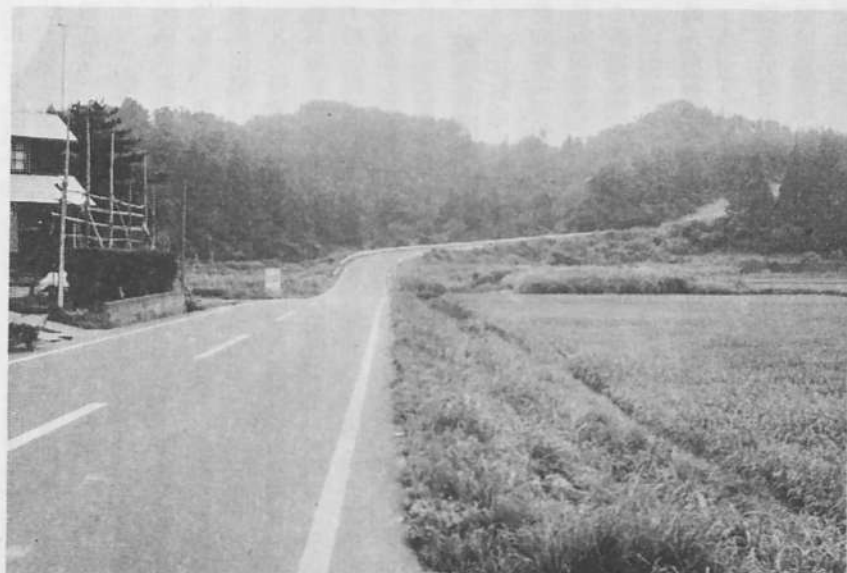
写真3 真殿坂断層上の県道、断層上の数10m間だけが陥落している
