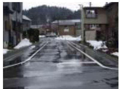
信越線側から見た避難道路
